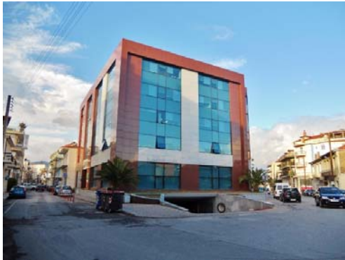
Εικόνα 3.5 Δημαρχιακό Μέγαρο οδού Λαγοπάτη
