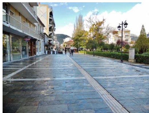
Εικόνα 3.82 Νέο Πεζοδρομημένο τμήμα της οδού Δημητρακοπούλου
