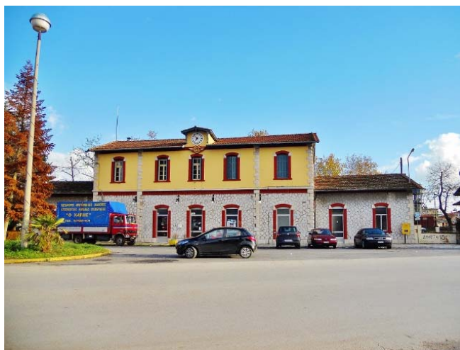
Εικόνα 3.70 Ο σταθμός του Ο.Σ.Ε. στην Τρίπολη
